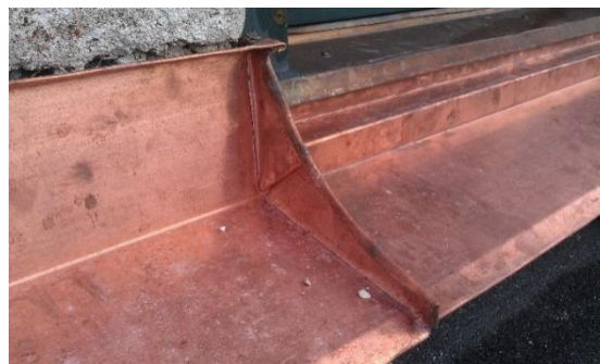
Plåtbeslag av koppar.
