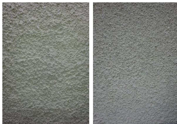
Handslagen puts till vänster och kompressor-sprutad puts till höger.
